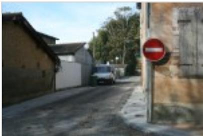
**Reprise du profil de la chaussée et création d'un trottoir bas avec récupération des eaux de pluie de surface. Travaux réalisés sous maîtrise d'ouvrage de la CCSG.**
